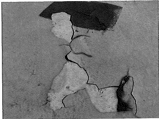
写真 2.1.2 防水層の破損の事例
