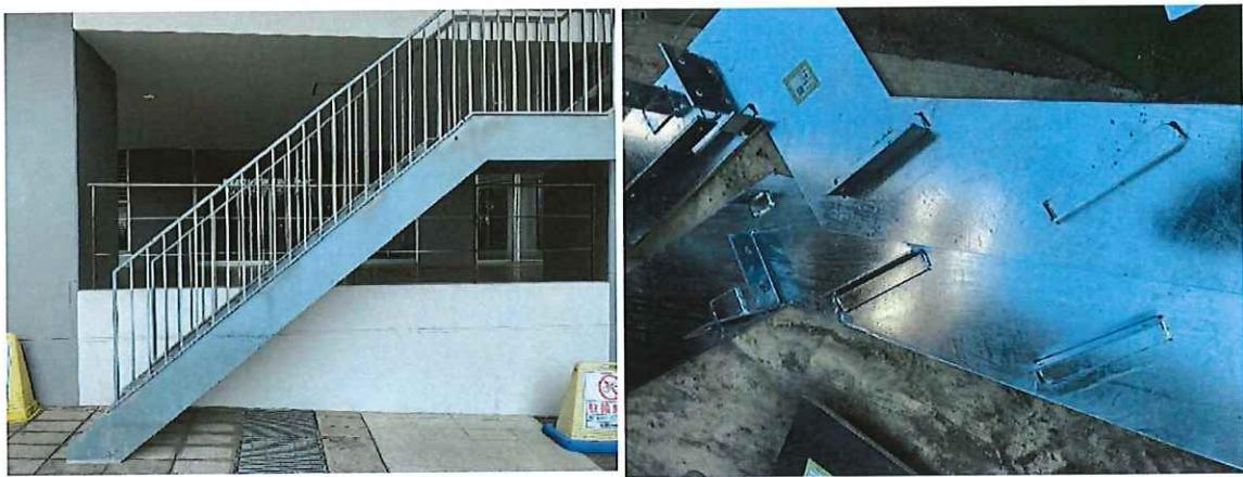
写真 1.3.4 塗料による防錆措置の事例
