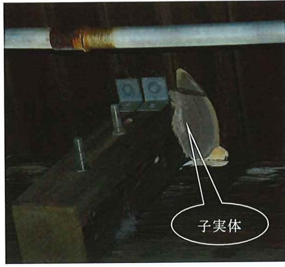
写真 2.2.6 木材腐朽菌の子実体の事例
