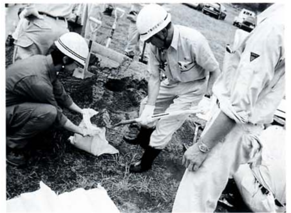
土嚢積み訓練状況
