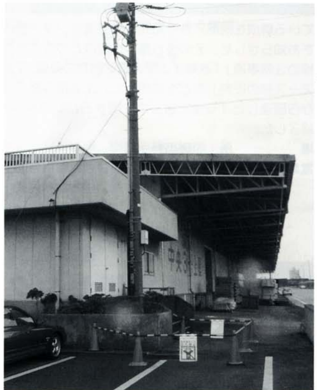
被害想定箇所の中央三号上屋
